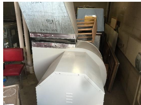
Image 19– Auditorium Return Fan
